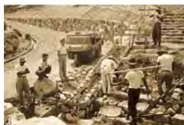
六甲海星病院の工事現場 1958（昭和33）年
